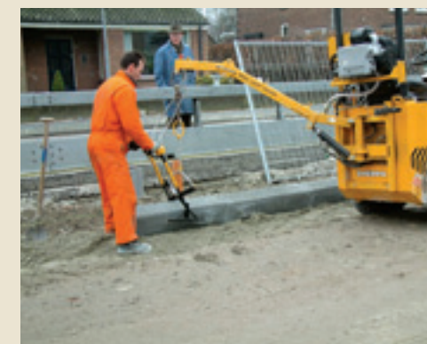
Een minishovel is een veelzijdige krachtpatser. Zelfs achter kan een hydraulisch armpje voor bijvoorbeeld een bandensteller.
