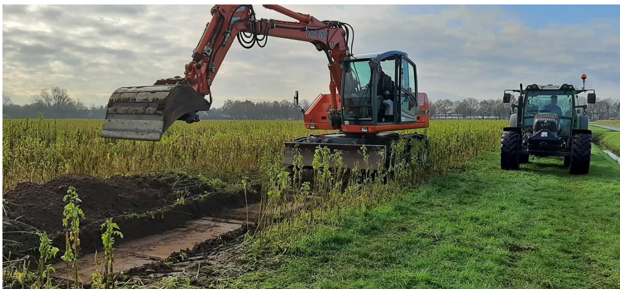
Figuur 3 Afgraven van de eerste 10 tot 20 cm van de bovengrond.
