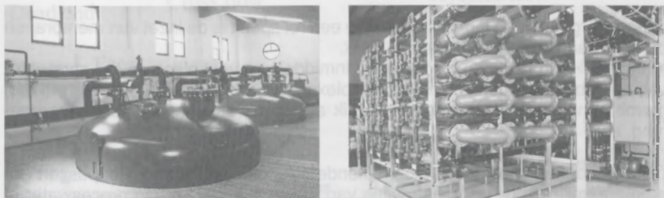
Figuur 8 . Full scale membraanbioreactor voor de behandeling van percolatiewater
