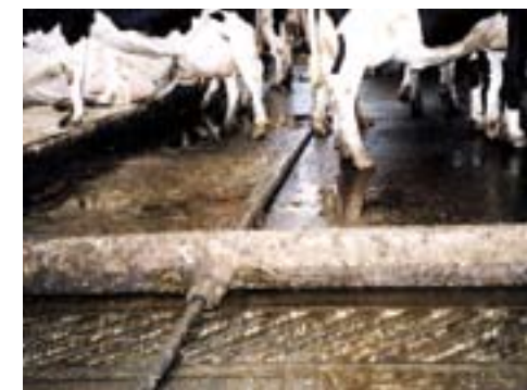
Een vlakke vloer met een afzetslot. De mest valt door de sleuven in de mestput. Voor een liggende koe is zo'n slot gevaarlijk. Een staart die in het slot ligt, wordt geamputeerd als de schuif voorbij komt.
