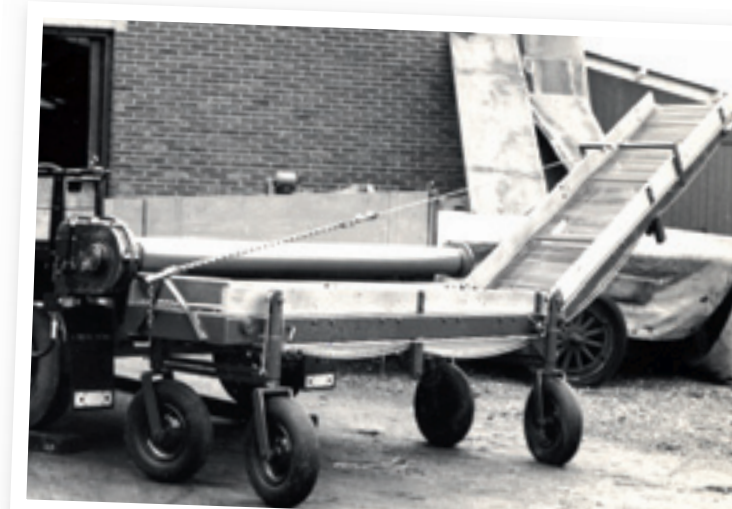
Met een losse zijafvoerband met opvoer gaf meer mogelijkheden om de loswagen met oproldoek op het bedrijf te lossen.
