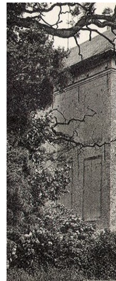
In de noordelijke zijgevel zijn de ramen (2x2) dichtgemetseld. Dit was ook het geval bij de zuidelijke zijgevel. Onder Frans bewind, vanaf 1798, gold belasting op deuren en vensters. Onder het Verenigd Koninkrijk der Nederlanden bleef de venster- en deurbelasting behouden en werd deze geïntegreerd in een personele belasting op basis van zes indiciën van welstand (naast deuren en vensters waren dit huurwaarde, haardsteden, meubilair, dienstboden en paarden). Deze belastingvorm bleef tot 1919 in zwang. Voor de overige ramen zal sprake zijn van gesloten luiken, overige prentbriefkaarten laten deze luiken zien.
