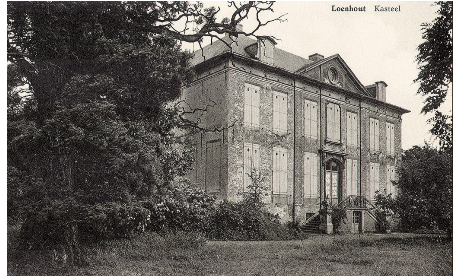
De westelijke gevel van het Huis, met een buitentrapp die aan weerskanten voor een kelderraam doorloopt. Mogelijk is de originele trap van rond 1745 vervangen door de nieuwe om daaronder een toegang tot de kelder te krijgen. De acacia van Fuchs op de voorgrond stond er in 1977 nog en is in 2023 verdwenen. Fuchs acacia op de achtergrond staat er nog, inclusief de afgestorven tak! Zie afbeelding in paragraaf 23.9, op p. 118.
