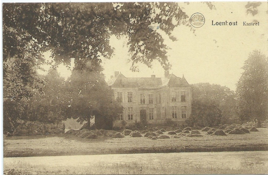
Gezicht op het Huis vanaf de oostelijke vijveroever. Het grasveld is gehooïd.
