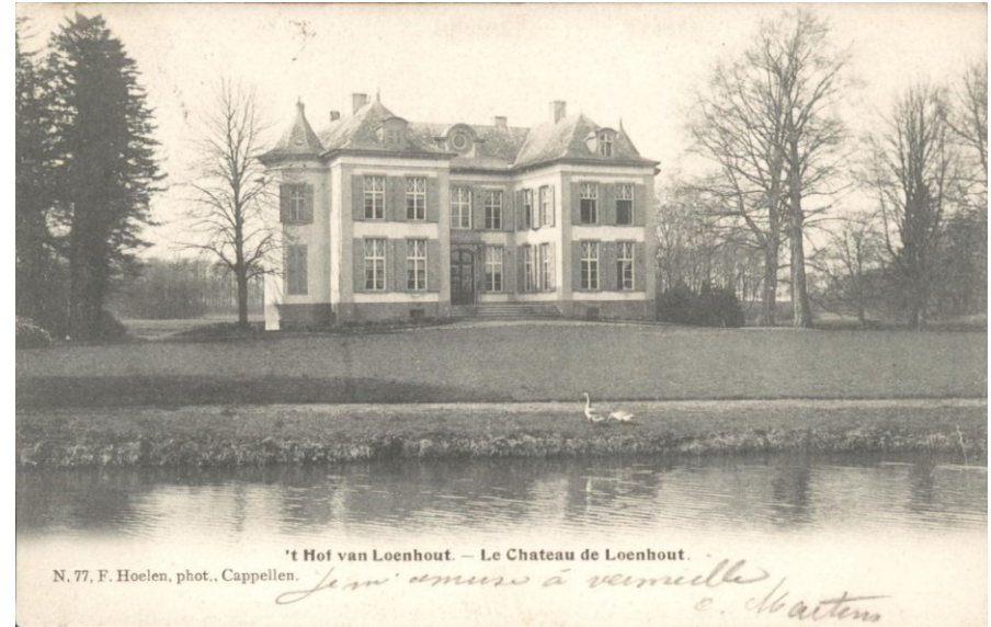
Gezicht op het Huis vanaf de oostelijke vijveroever (1904).
