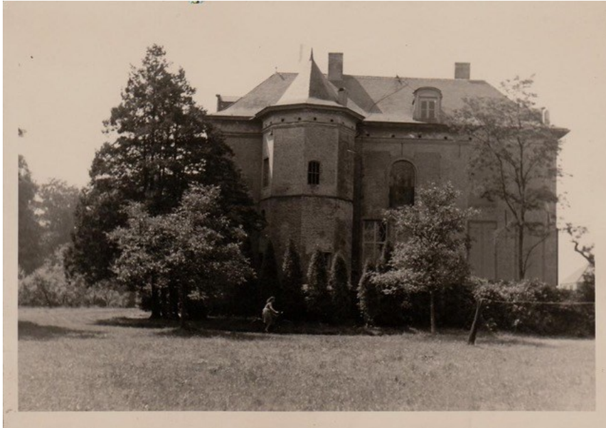
De noordelijke gevel van het Huis.
