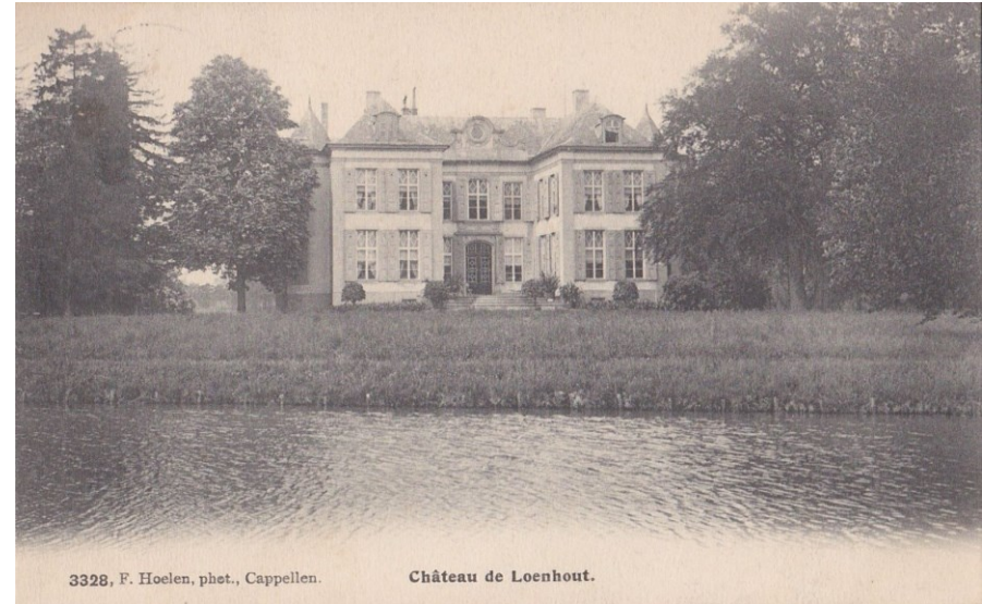
Gezicht op het Huis vanaf de oostelijke vijveroever (1907).
