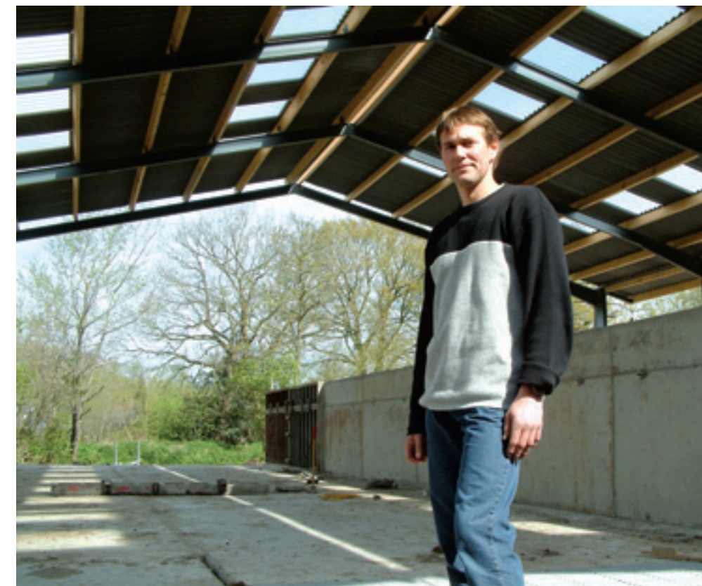
Jacob Noord in de in aanbouw zijnde sleufsilovoedering. Zijn 65 koeien produceren gemiddeld 8.200 liter melk en worden gemolken met een melkrobot.
