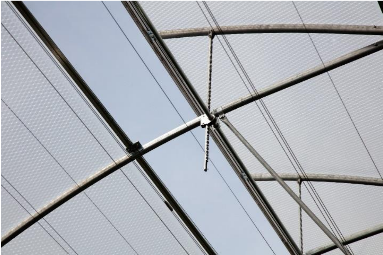
Figuur 4 Luchtraam van de doorlopende nokluchting, bedekt met noppensfolie.
