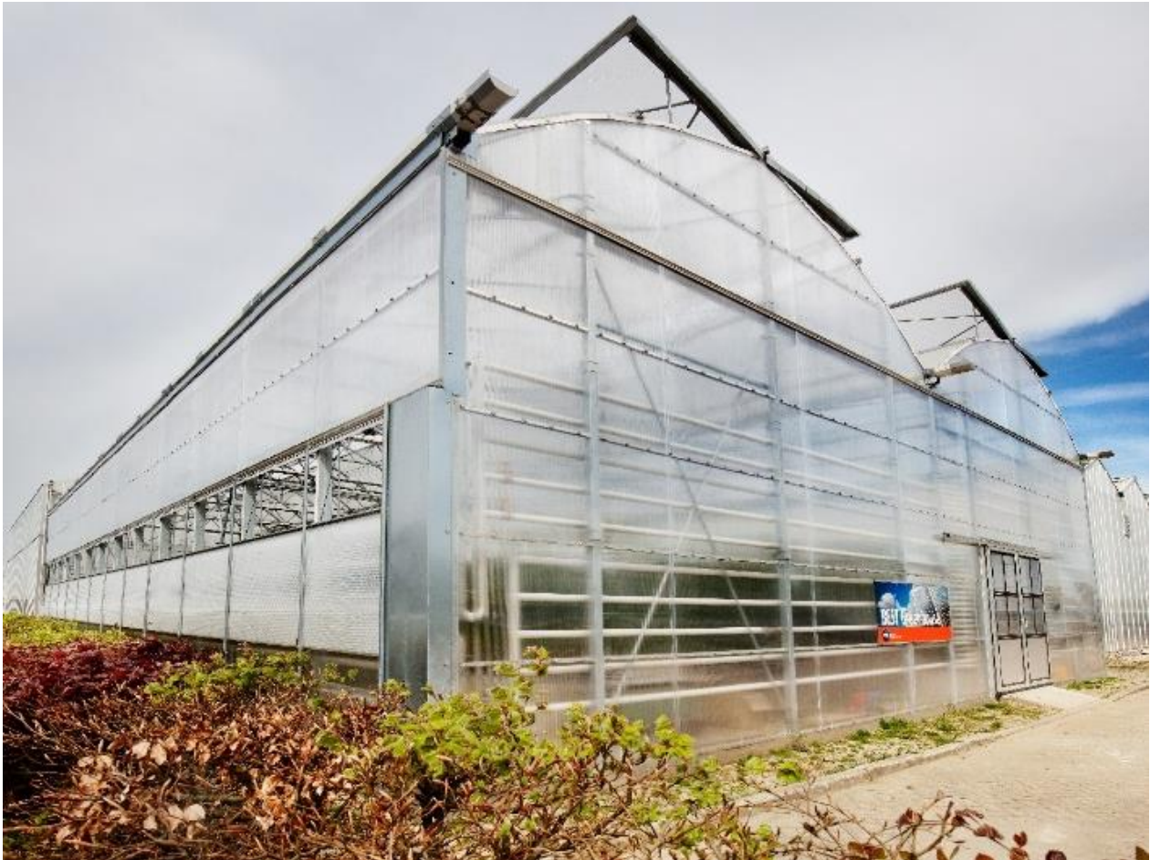
Figuur 2 Buitenaanzicht van de BEST-kas. De gevelventilatie en nokluchting zijn te zien, evenals de gevelverwarming.
