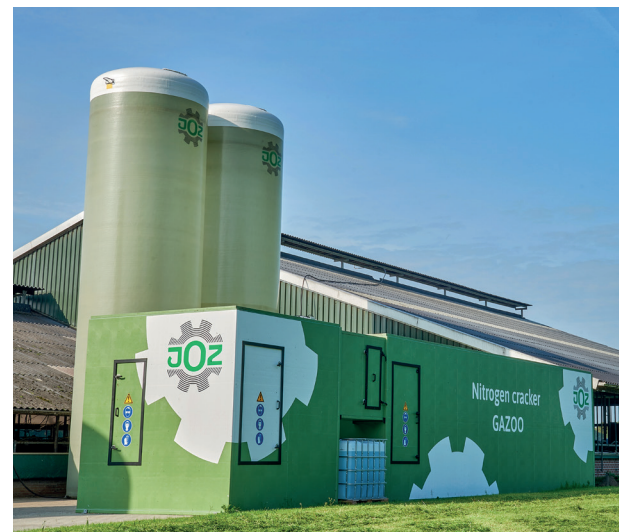
De stikstofkraker Gazoo van JOZ produceert een spuiroom die ingezet kan worden als kunstmestvervanger
