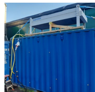
Foto 4 Container met koelunit en boven op de droogkoeler.
