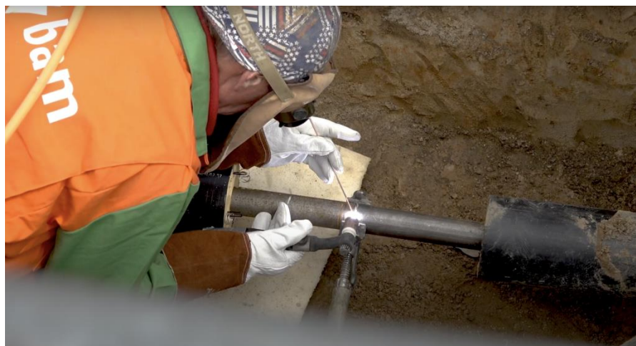
Figuur 1. Aanleg van het warmtenet in Didam, een stalen aansluitleiding wordt gelast ( www.firan.nl ).
