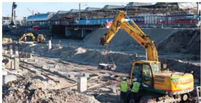
FOTO 2: GRONDWERKZAAMHEDEN IN HET STATIONSKWARTIER.
