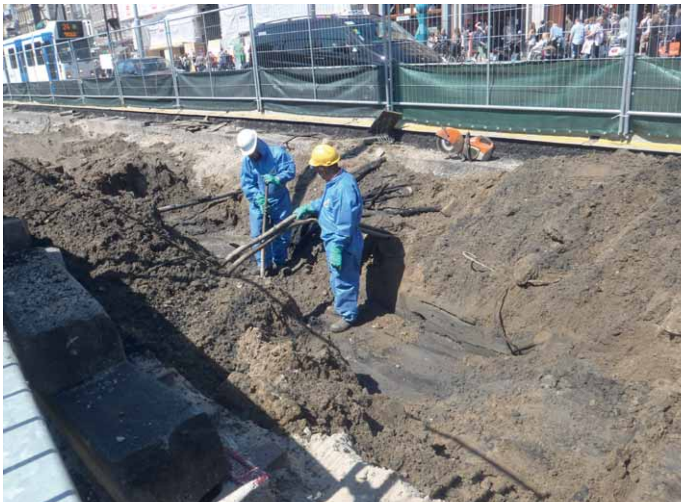
FIGUUR 1: UITVOERING VAN WERKZAAMHEDEN IN T-KLASSE.
