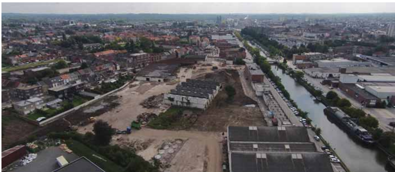
FOTO 1: AALST - CONVENANT 82 PIER KORNEL-OORSPRONKELIJKE TOESTAND NA SLOOP.
