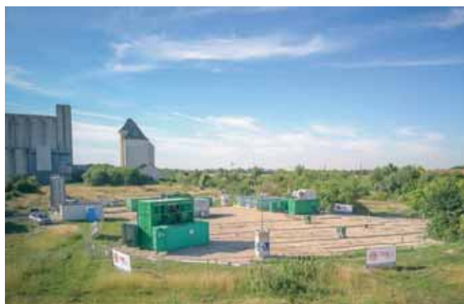
FIGUUR 5: UITVOERING VAN EEN ERH SANERING IN NOORD-FRANKRIJK.
