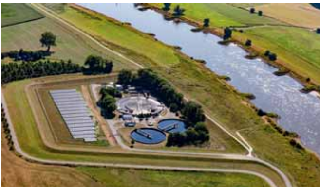
FIGUUR 1: RWZI BRUMMEN MET ZONNEPANELEN.
