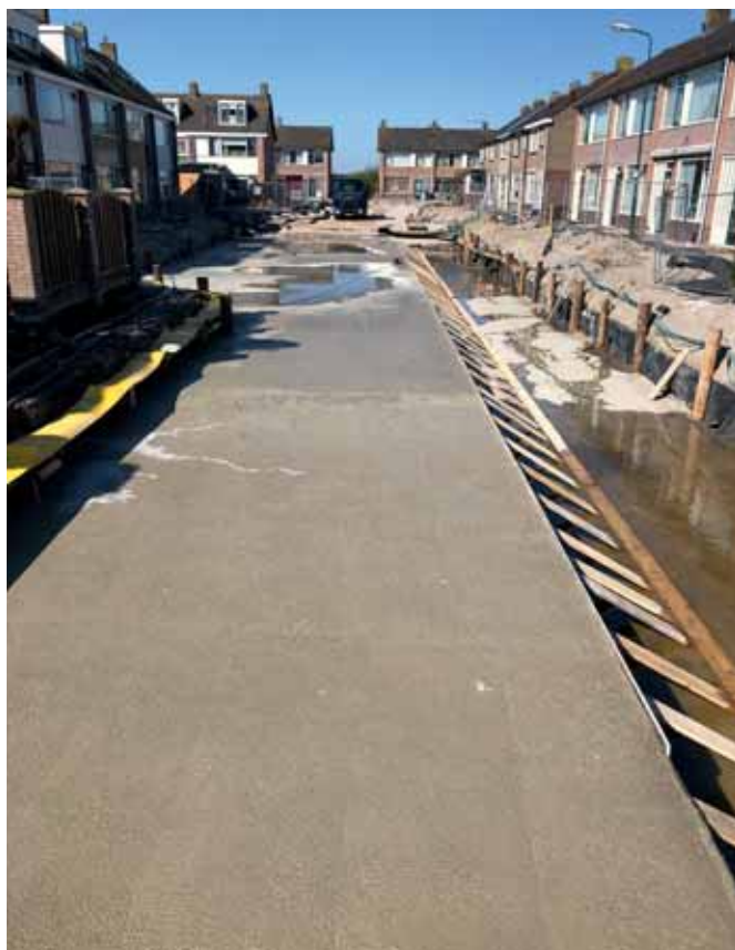
FIGUUR 2. BEELD VAN AANLEG FUNDERING VERHOOGDE WEG (LINKS) EN NUTSLEIDINGSENTRACÉ (RECHTS)
