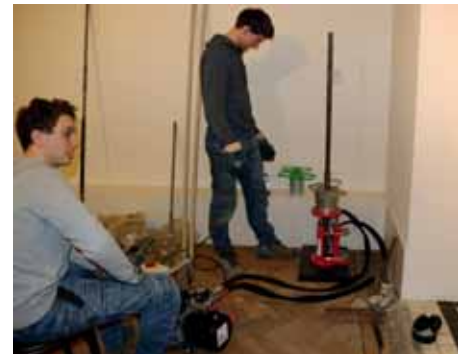
OP DE FOTO ZIJN MARIJN EN ANDRÉ BEZIG MET EEN BODEMONDERZOEK VOOR HET UITBREIDEN VAN EEN KELLER IN HET CENTRUM VAN AMSTERDAM. DOOR DE PUINHOUDENDE BODEMLAGEN IS HET GEBRUIK VAN EEN RAMGUTS EN HYDRAULISCH UITTREKSYSTEEM ESSENTIEEL.
