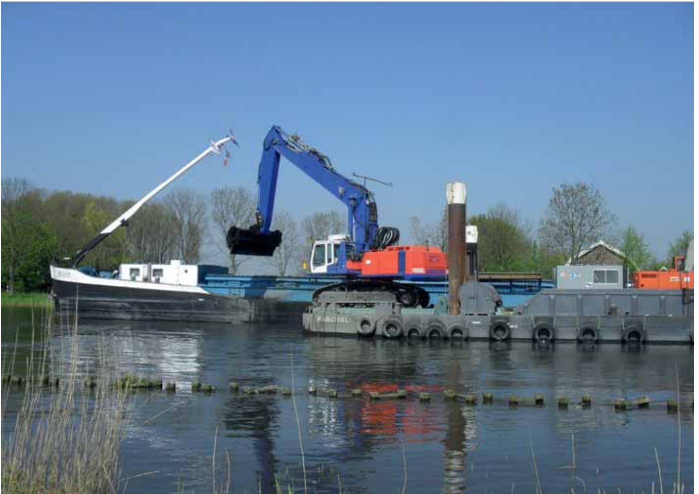
FIGUUR 3: HET UITEINDELIJK BAGGEREN VAN DE WATERBODEM.
