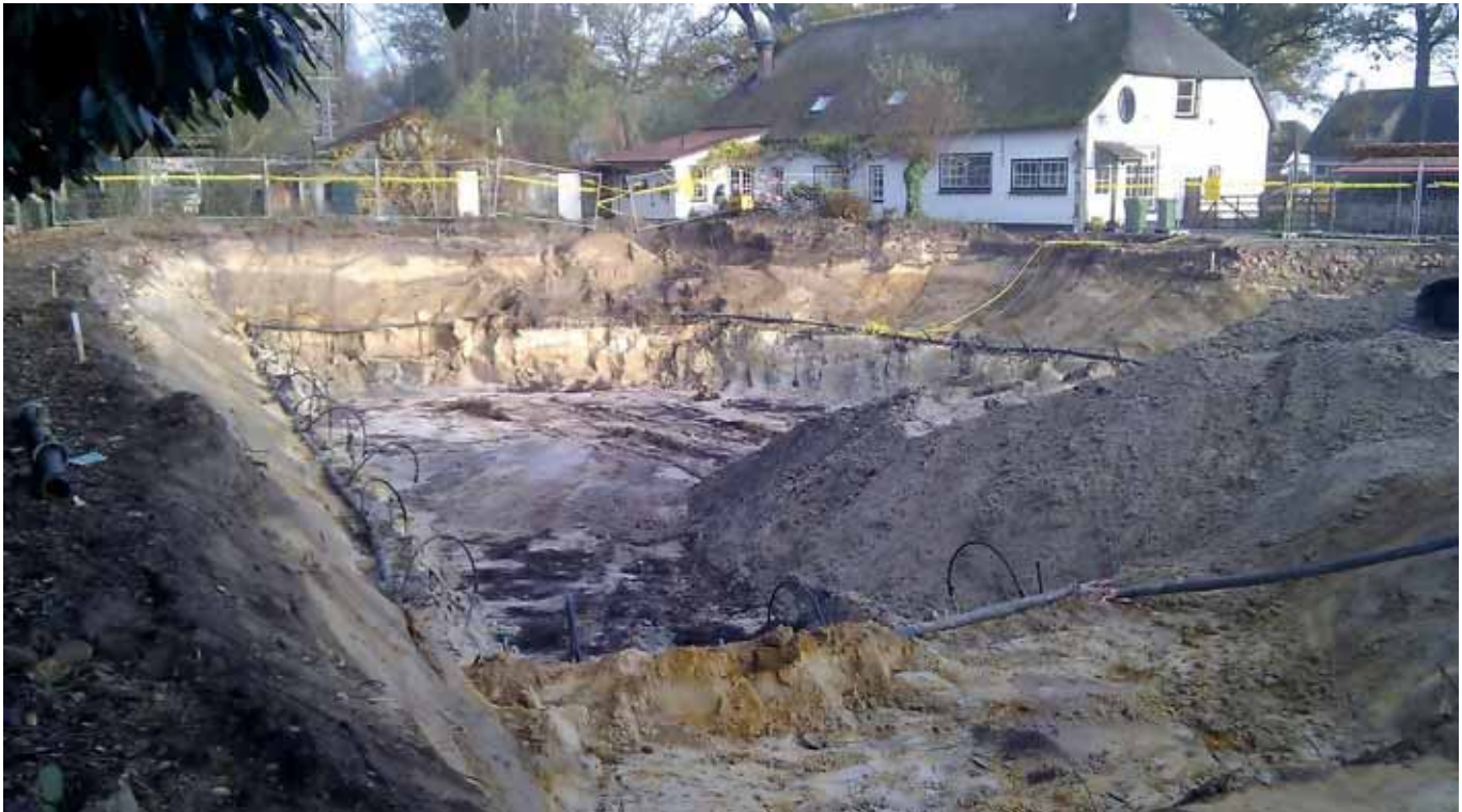
OVERZICHT SANERINGSLOCATIE NA ONTGRAVING
