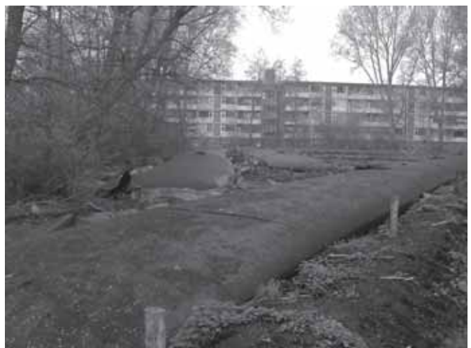
FOTO 2. DE BAGGER IN DEZE GEOTUBE MOEST IN 2005 WORDEN AFGEVOERD. MET HET NIEUWE BELEID MAG DE BAGGER TER PLAATSE WORDEN VERWERKT (FOTO AT MILIEUADVIES).
