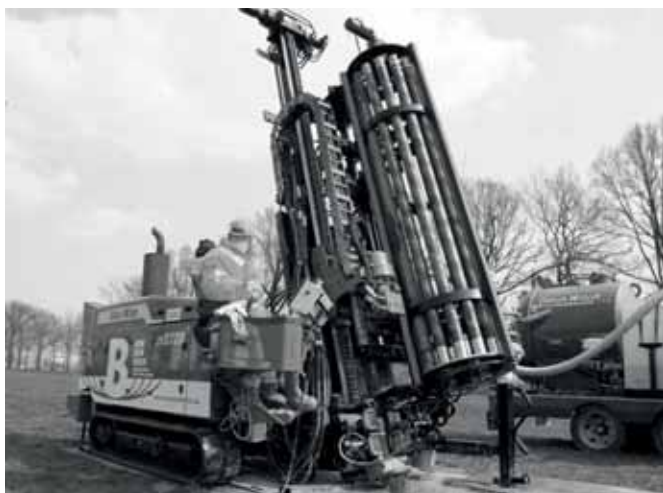
FOTO 3: SPECIALE BOORMACHINE VOOR HET BOREN VAN EEN AARDWARMTEWISSELAAR MET SNELLE BUIZENLADER.
