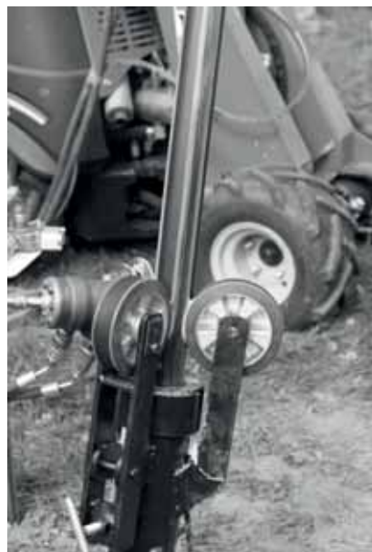
FOTO 4: DE AARDWARMTEWISSELAAR WORDT INGEVOERD DOORMIDDEL VAN EEN HYDRAULISCH APPARAAT.
