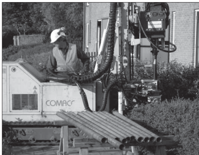
FIGUUR 1. RUPSANDVOERTUIG OM DIRECTE INJECTIES MEE UIT TE VOEREN.
