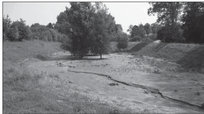
FOTO 3. MODDER NA EEN HEVIGE REGENBUI OP 27 JUNI 2009 (IN DE REGENWATER-BUFFER ETZENRADE. TIJDENS EN DIRECT NA DE BUI WAS DEZE REGENWATERBUFFER GEHEEL MET WATER GEVULD. DE LEEGLOOP GEBEURT DAN IN ± 24 UUR.
