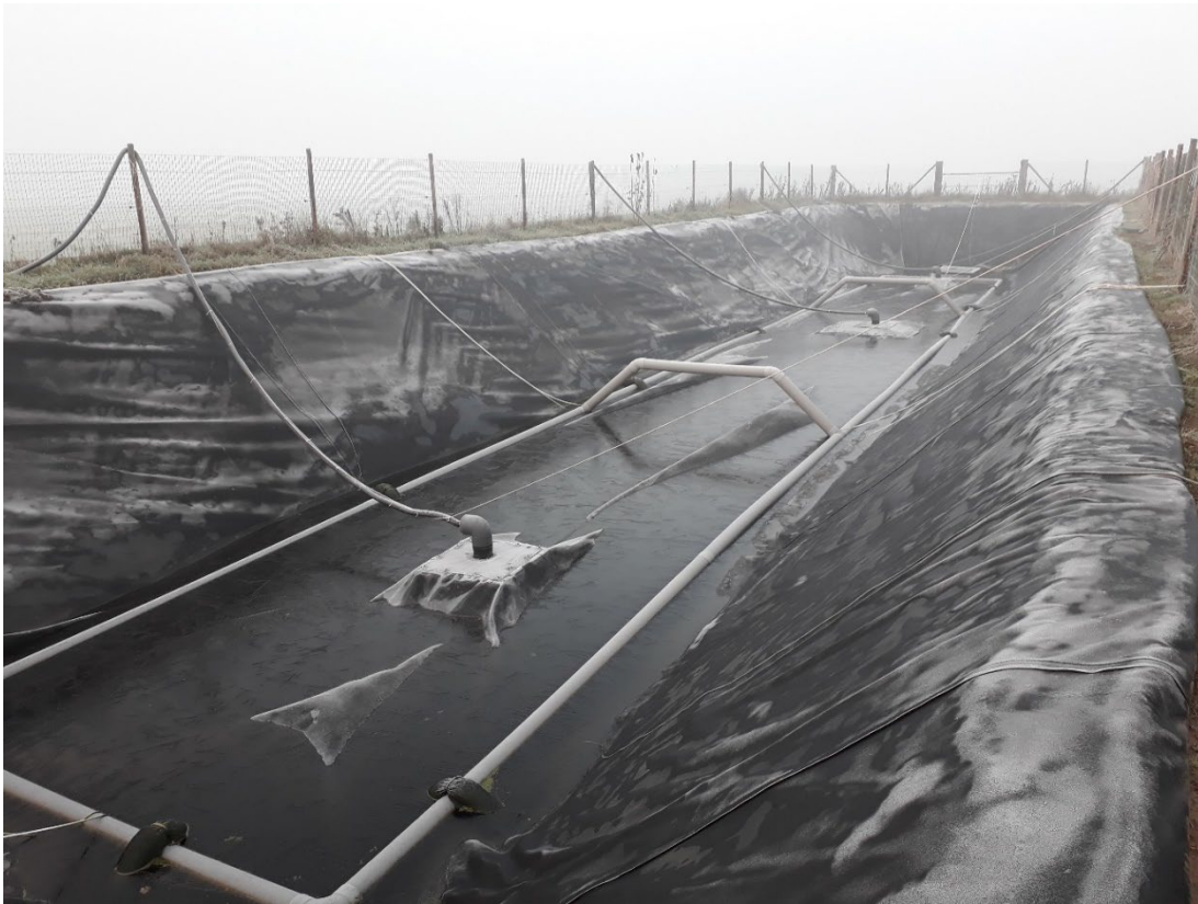
Figuur 13 De mestopslag in januari 2020 na vulling.
