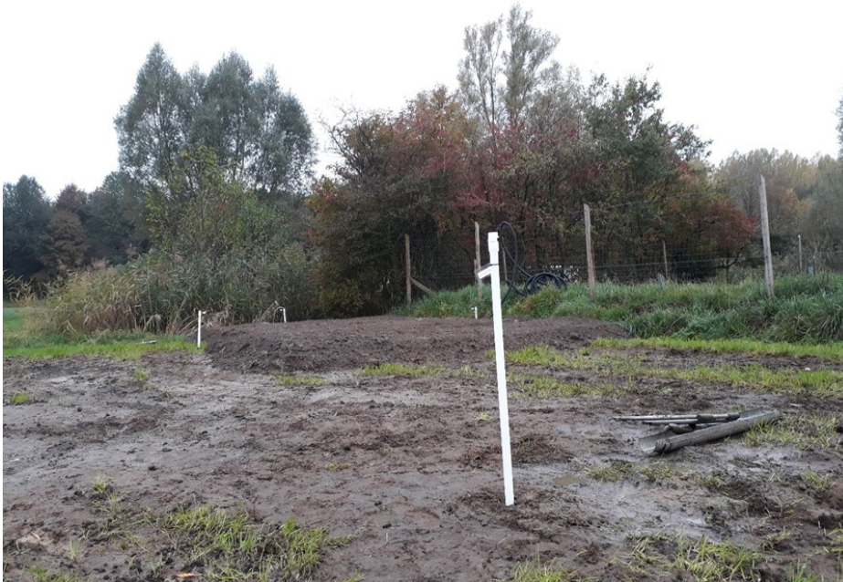
Figuur 19 De witte buizen zijn waterpeilbuizen die op verschillende dieptes rond het bodemfilter zijn aangebracht om de grondwater kwaliteit te monitoren.
