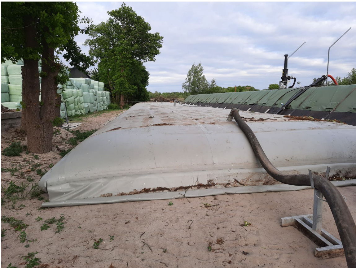
Figuur 7 Foto van de mestzak met vooraan de mestaanvoer. Middenop is de grijze gasafvoer net zichtbaar, aangesloten op een flexibele slang.
