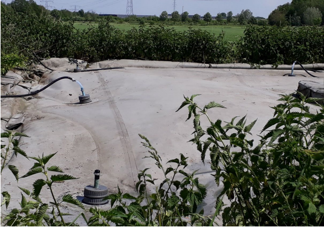
Figuur 4 Foto van de met daarop de afgedopte ontluchtigsgaten in de hoeken en aansluiten van een flexibele slang op de middelste ontluchtigspijpjes.
