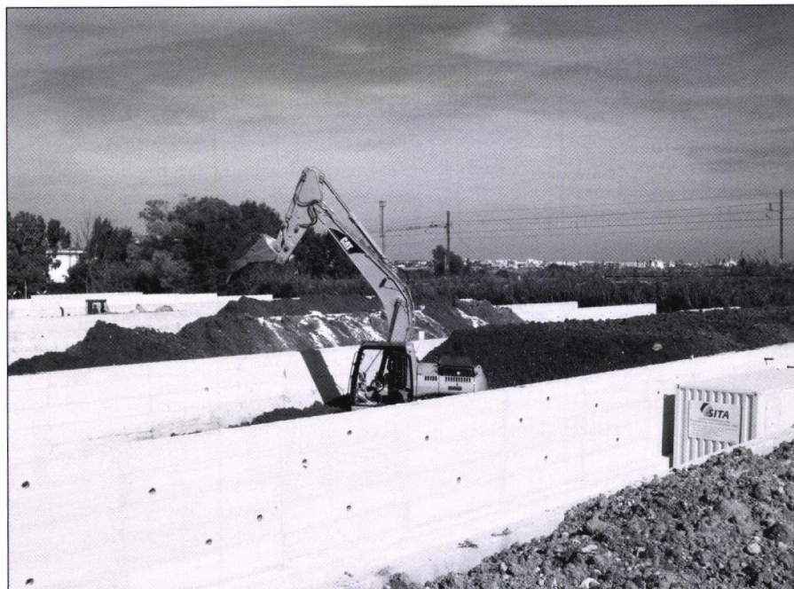
AANLEG VAN BIO-PILES IN SICILIË (ITALIË) SITA REMEDIATION®
