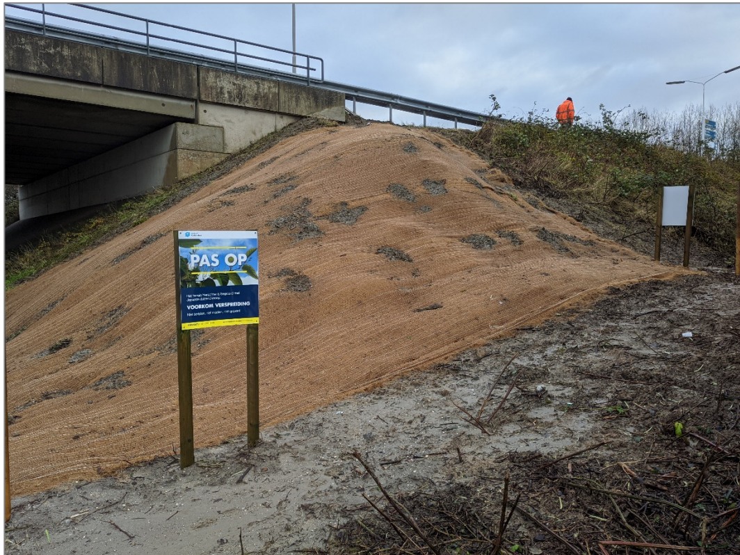
Figuur 15. JDK-127 in het talud van het viaduct Europaweg – Stenen Baakplein, afgedekt met biobased Duracover en kokosmat.
