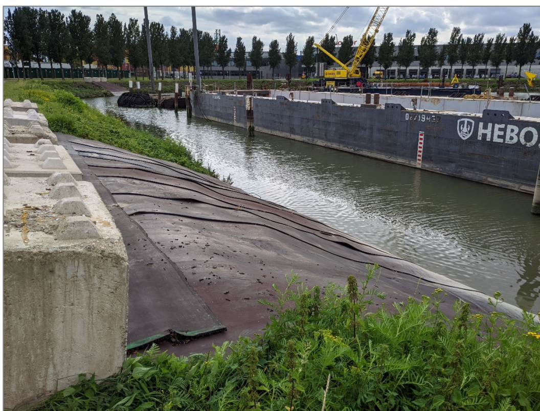
Figuur 18. JDK-081 Quarantaineweg na aanbrengen transportbanden. Situatie 13 september. Op de achtergrond JDK-080.
