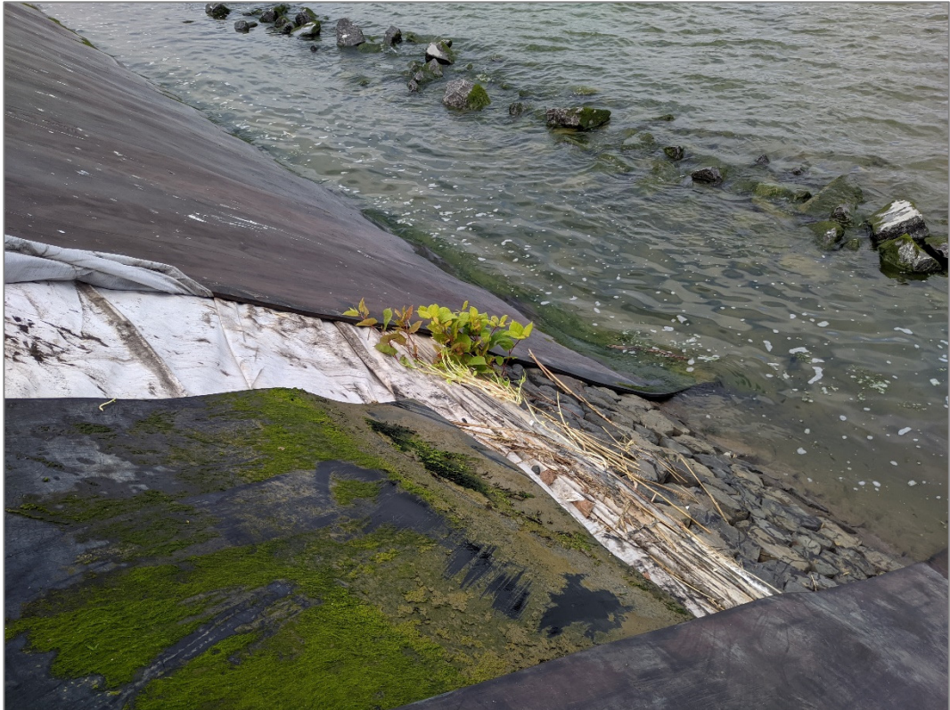
Figuur 16. Afdekking van JDK-096 aan de Wartlastraat op 30 mei 2023. Het witte doek onder de transportbanden is door de golfslag opgestroopt tot boven de onderste duizendknoopscheuten.
