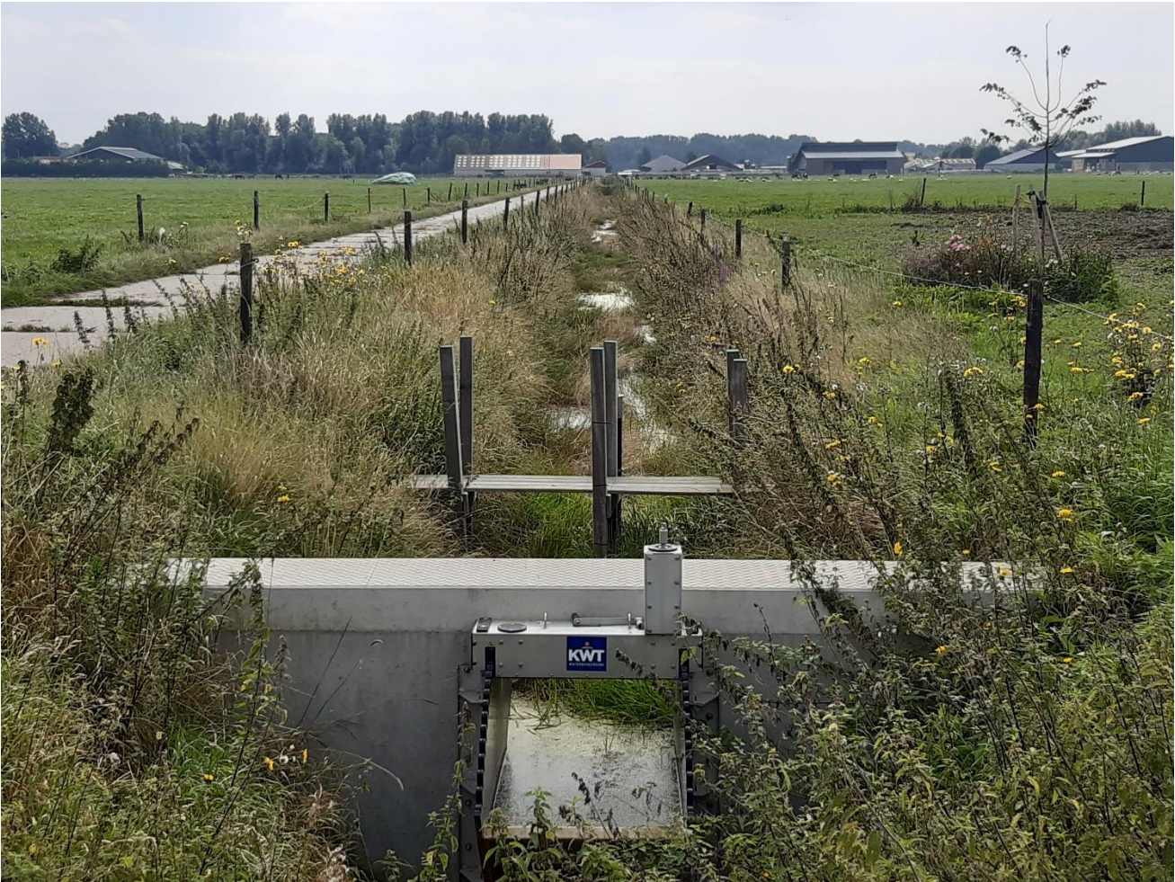
Afbeelding 4. Helofytenloot met stuw, sensoren en helofyten
