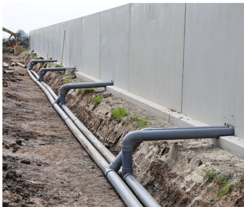
Figuur 1. Aanleg van afvoer van een duogoot. Deze voert perssapp af naar een opslag en neerslag naar het oppervlaktewater.
