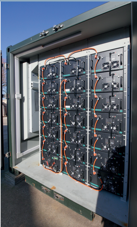
De nieuwe batterijen bestuderen zelf de elektriciteitsmarktprijs. Ze laden op of injecteren stroom op het net als dat financieel het meest rendabel is
