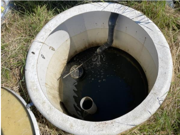
Figuur 10 Betonnen regelput op het proefblok op Proefboerderij Rusthoeve.
