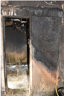
Afbeelding 10: Deurconstructie vanuit technische ruimte naar het tanklokaal.
