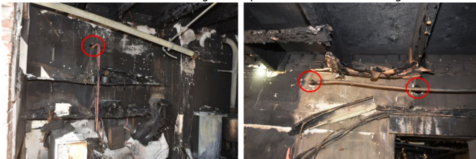
Afbeelding 11: Doorvoeringen in de wandconstructie van de technische ruimte naar het tanklokaal.
