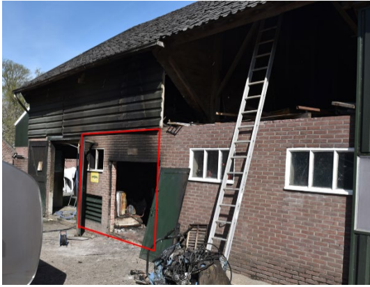
Afbeelding 13: Mogelijk traject brandoverslag vanuit de gevelopeningen.
