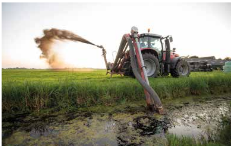
Om de sloot op diepte te houden, is het beter om regelmatig met de baggerspuut een kleine laag baggerspecie te verwijderen. Dit moet ongeveer eens in de vijf jaar gebeuren.
