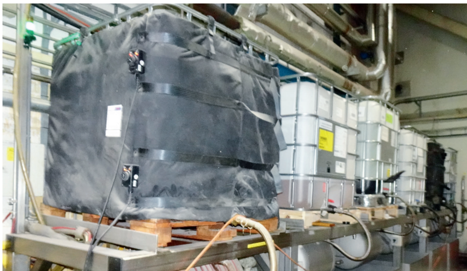
Foto 3: Een rij containers met vloeibare ingrediënten. De vloeistof stroomt vanuit de container naar een vat onder de container en wordt vervolgens naar de menginstallatie in de fabriek gepompt. Zodra de container leeg dreigt te raken, wordt semi automatisch een volle container aangevoerd, zodat het mengproces niet wordt onderbroken.
