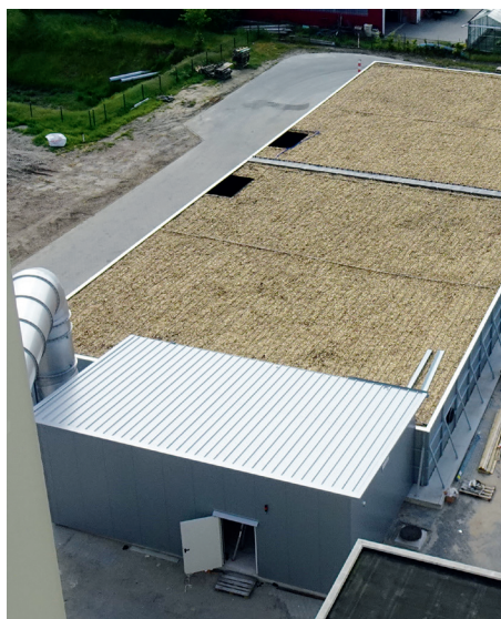
Foto 13: Het nieuwe luchtfilter van boven gezien. De wasruimte van de lucht is te zien als grote zilveren doos vóór het filter; van daar gaat de te reinigen lucht naar het filter met boomwortelsnippers, het oppervlak daarachter.
