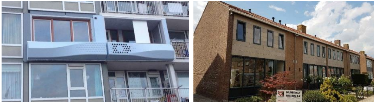
Figuur 21 Biocomposiet gevelpanelen; links met daarin een lucht-warmtepomp; rechts als bekleding van de 1 e verdieping. Foto's NPSP.
