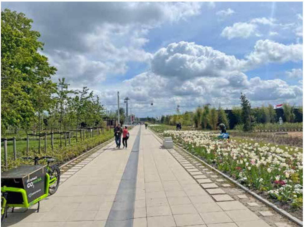
Een toekomstige straat van de woonwijk met in het midden de afvoer van regenwater.
