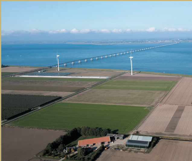
Uitzicht op de Zeelandbrug met een stukje polder met karakteristieke weidsheid. (foto uit Beeldbank Zeeland)
