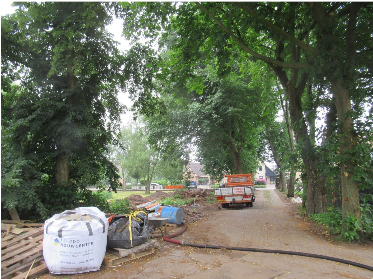
De laan tijdens bouwwerkzaamheden
