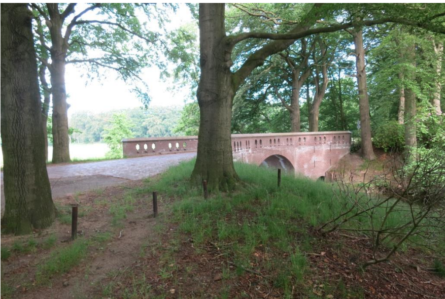
afb. 18 2016 De monumentale bakstenen boogbrug van de Valkeveenselaan met oude beuken aan weerszijden.
