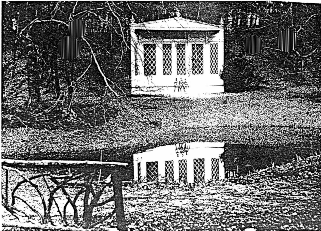
Afbeelding 3 Aan het einde van de zichtas stond een houten gebouwtje, foto GAW.
