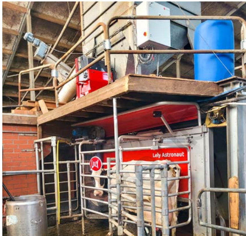
De installatie op het melkveebedrijf van Johan Vanhecke in Maldegem.
