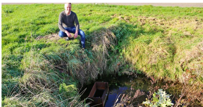
Figuur 1. De geplaatste stuw voor een duiker (later vervangen door een hoger type).
