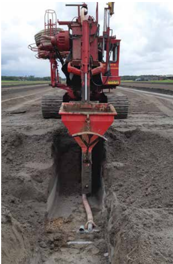
Afbeelding 2. Het leggen van drainagebuizen en ijzerzand
