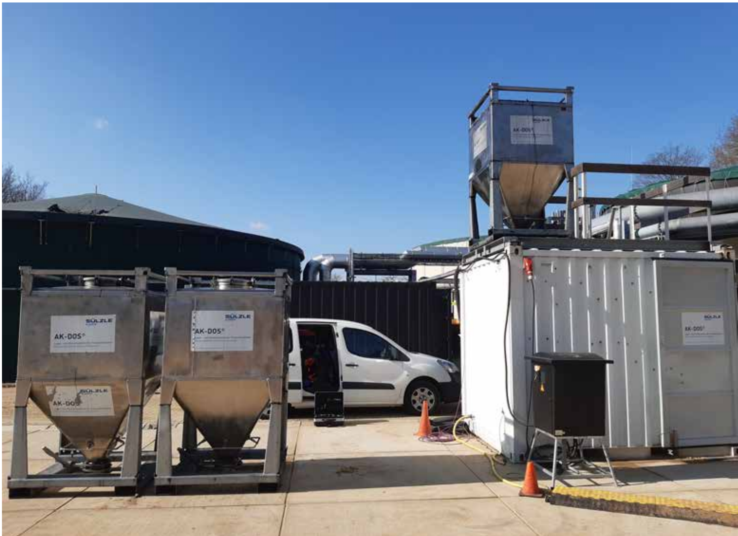
Rwzi Simpelveld: Poederkooldoseerunit (rechts) en voorraad poederkool (links)
