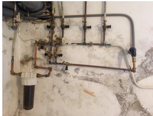
‘Doe het zelf’ koppeling tussen regenwater en drinkwater systeem in huis.
