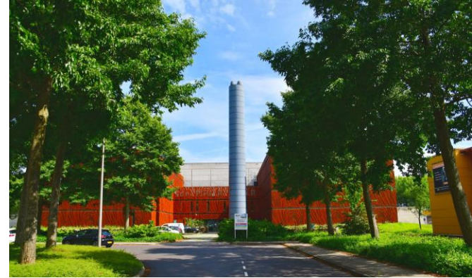
Biomassacentrale Purmerend (boven) en Andijk (beneden)
