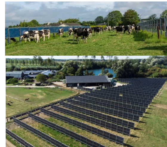
Zonnepark Den Heuvel, Culemborg: combi met melkveehouderij en asbestsanering staldak
