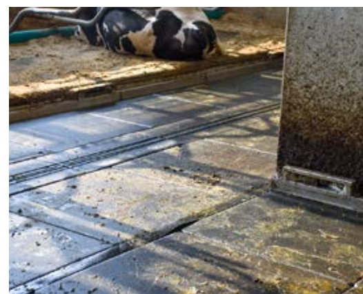
Experiment met scheiding van mest (die boven blijft) en urine (die door het doek zakt) om ammoniakvorming te voorkomen.
