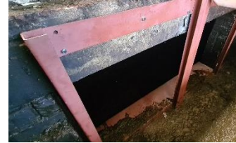
Foto 1 Schot tussen gekoelde en niet gekoelde tussen-mestkelders.
