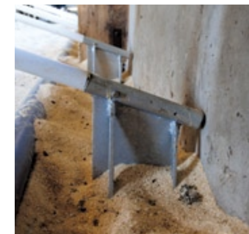
De galvaniseerde houders worden op de vlakke betonnen vloer geschroefd.
