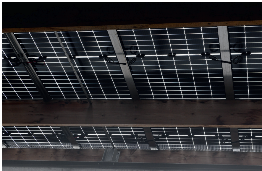
Op de stal ligt een zaagtanddak. De bovenste helft van de dakdelen is voorzien van lichtdoorlatende zonnepanelen
