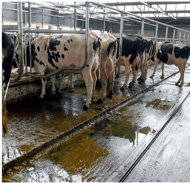
Achter het voerhek is een verlengde voerstoep gerealiseerd. De urine loopt naar een goot en wordt direct afgevoerd
